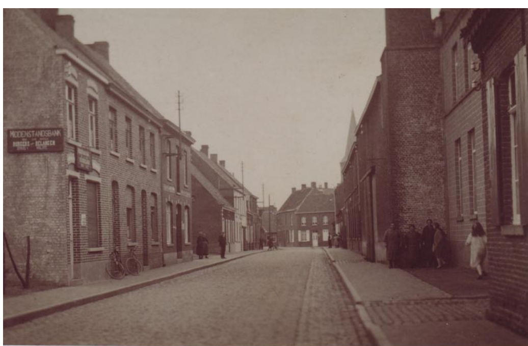
Zicht op de Brugsestraat richting Hulstedorp. De Gareelmakerij/HetSportpaleis zie je aan de linkerkant vóór de drie mensen.
